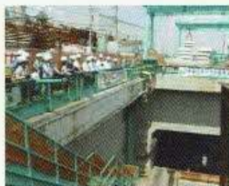
▲北西線現場見学会(7月31日)
